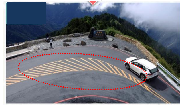
中央分隔槽化加寬
